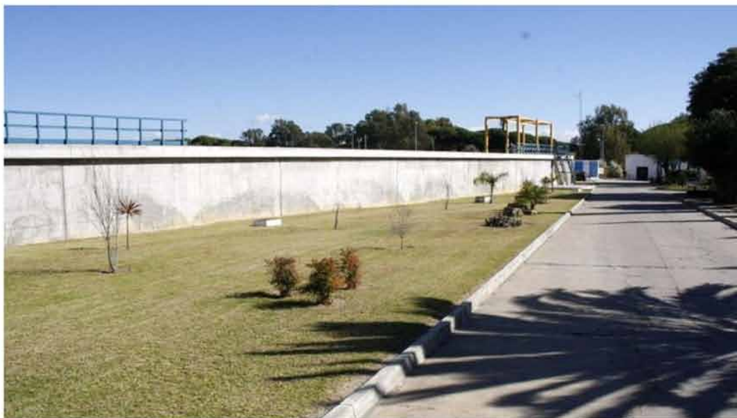
Una imagen del interior del recinto de la depuradora de Las Galeras, en El Puerto. / D. C.
