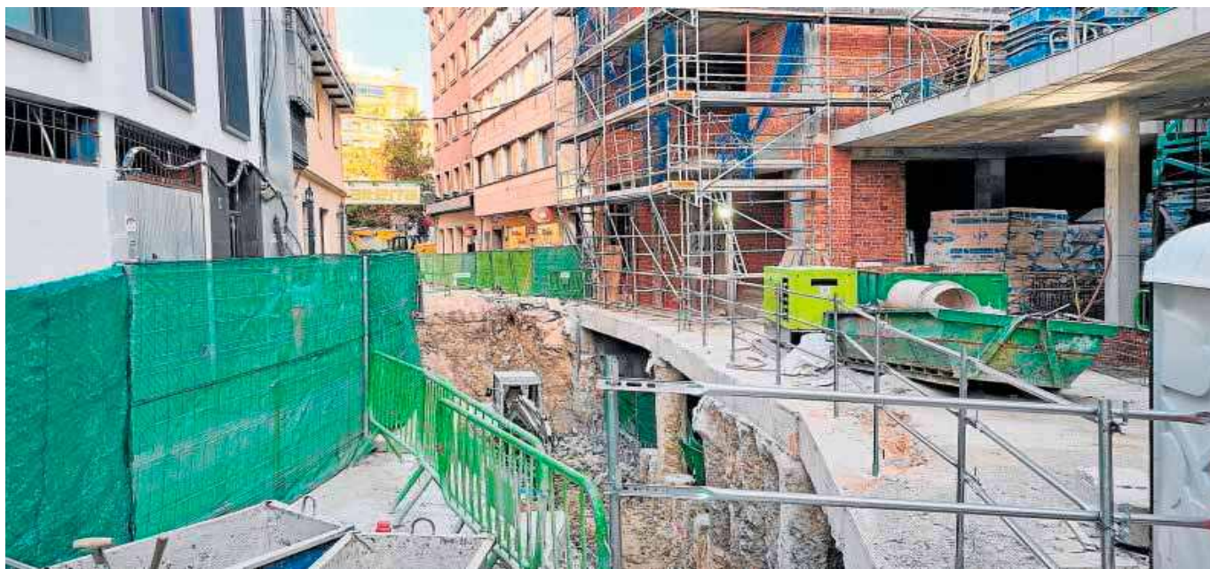
La calle San Clemente, levantada para conectar el edificio del antiguo solar de Simago con el parquin de la plaza de la Constitución. LIÉBANA
