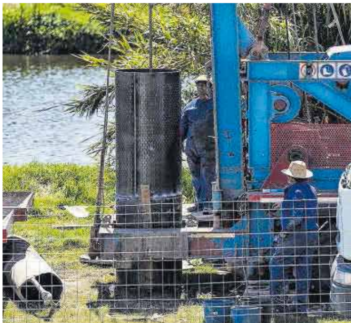
Obras para construir pozos en el río Besòs, ayer en Sant Adrià.
